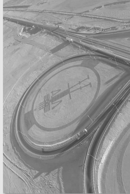
Toesca Infraestructura I
