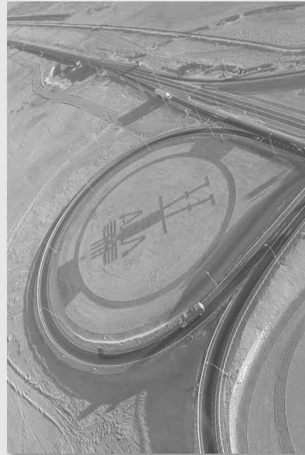
Toesca Infraestructura I
